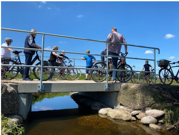
Die Teilnehmer begutachteten die gerade fertiggestellte neue Beekmoorbrücke (Foto Chr. Enste)
